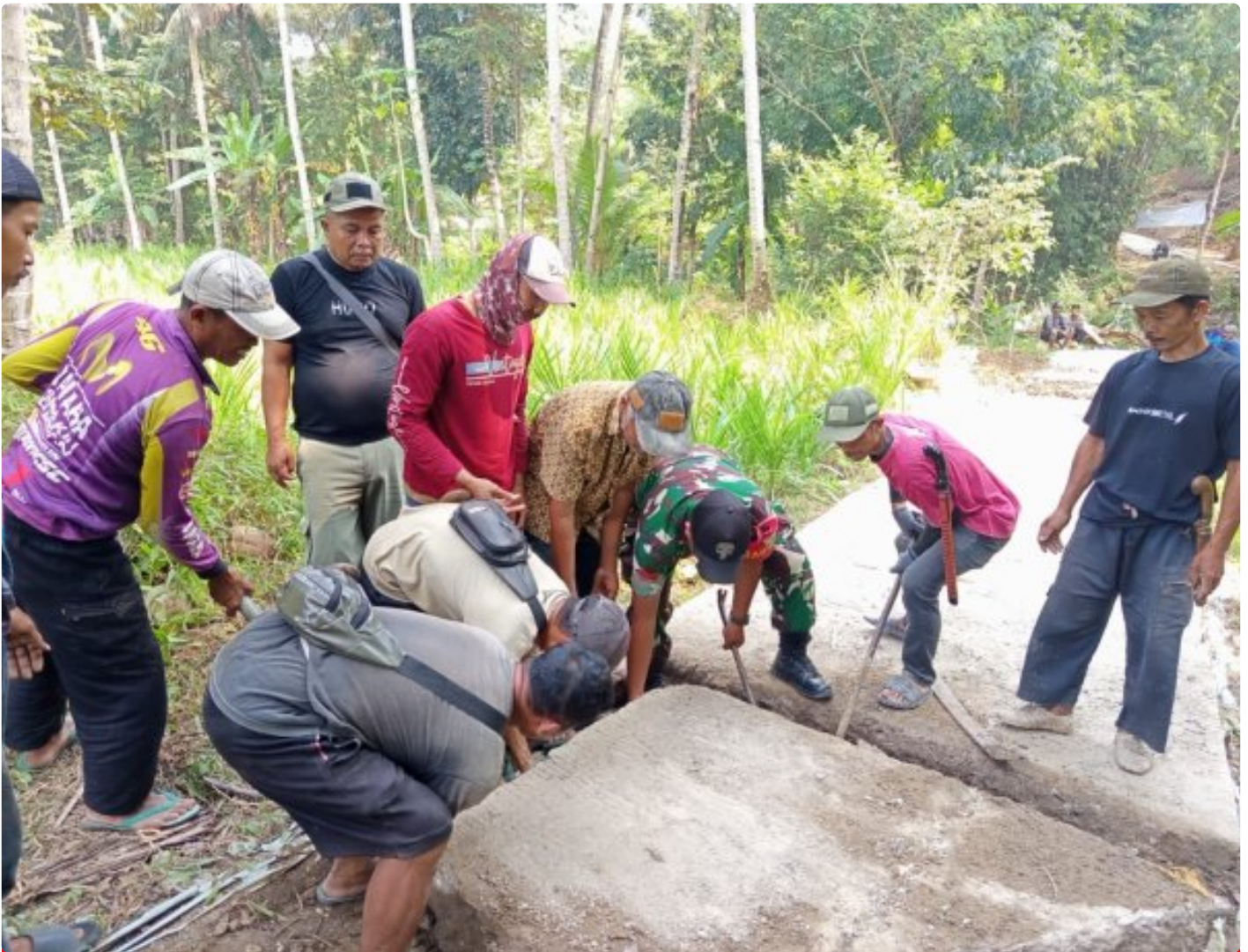
Pembangunan Jembatan Gantung di Desa Sukamulya Perkuat Konektivitas Warga
